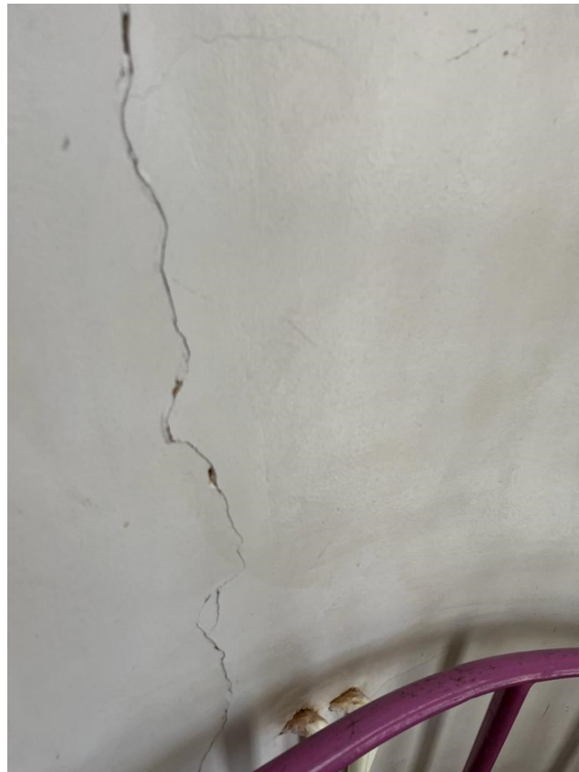
Slika 10. Pukotine žbuke na stubištu – k.č.br. 2814/1
