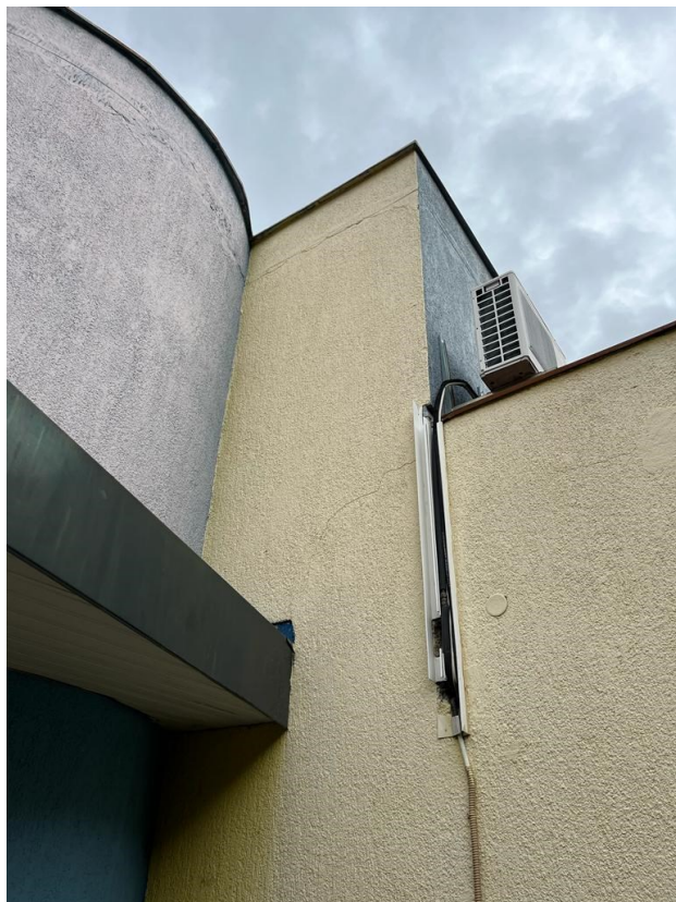
Slika 5. Manje pukotine žbuke na zapadnom pročelju – k.č.br. 2814/1
